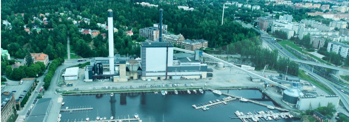
Elektrociepłownia przed modernizacją. Źródło: www.naistenlahti.fi
