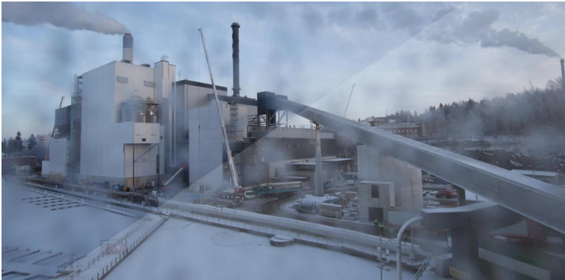
Budowa nowego kotła fluidalnego wraz z gospodarkami. Źródło: www.naistenlahti.fi
