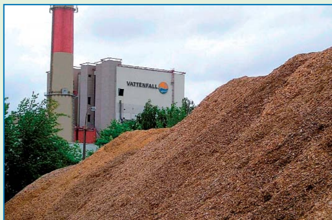
EC Żerań – widok budynku kotłowni, składu paliw z 2009 r.
